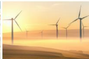
Instalación de Viento Grande
