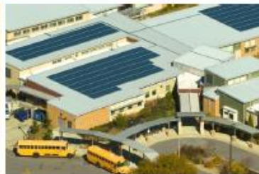
Instalación Solar Local
